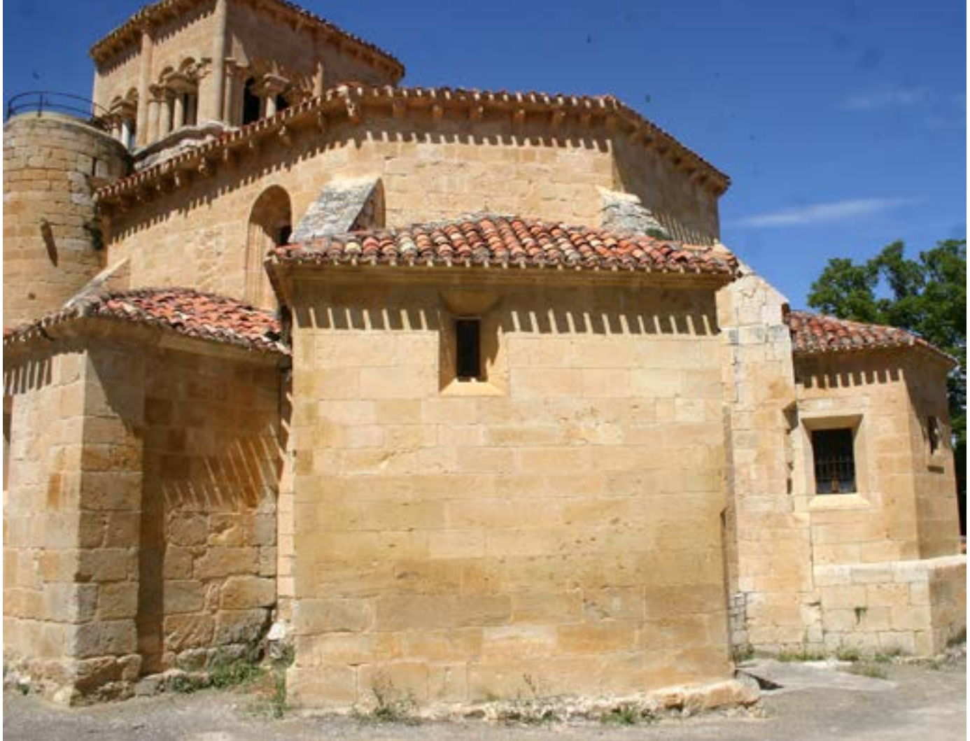
Exterior de la capilla funeraria de Agustín Hernández de la Gala en la iglesia parroquial de El Almiñé.
