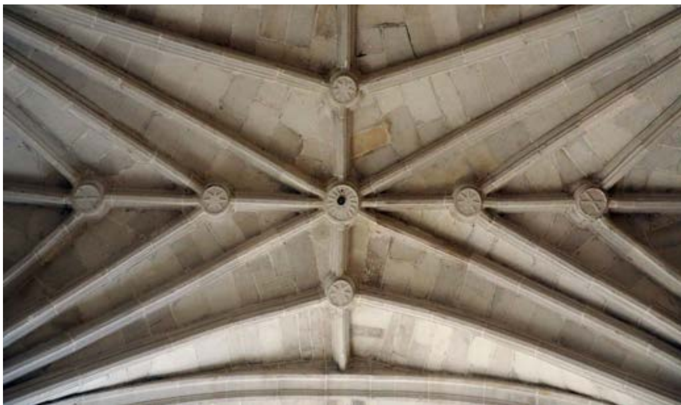
Bóveda del coro de la iglesia de Ros.
