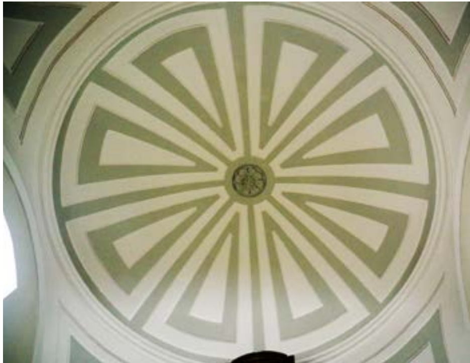
Bóveda de la capilla mayor de la iglesia de San Antón de Burgos.
