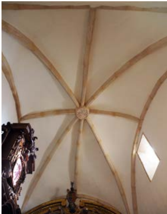
Estado actual de la bóveda de la capilla de Simón Gómez de Salazar en la iglesia de Santa María de Salazar.
