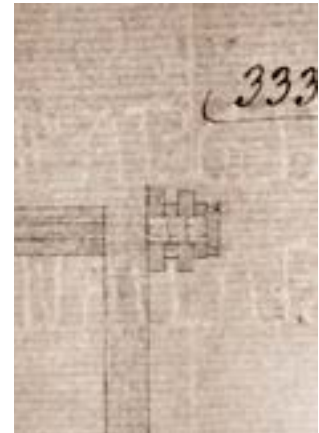
Construcción del coro de la iglesia de Ayuelas (Prot. Not. 4.207/1, f. 333)
