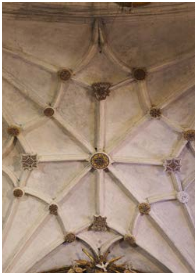
Bóveda de la capilla mayor de la iglesia de Zael.
