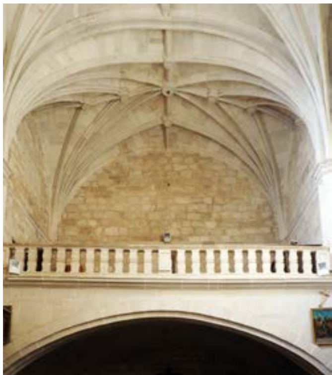
Bóveda del coro de la iglesia de Ros.
