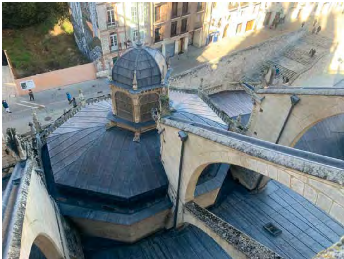
Fig. 30. Tejado de la capilla.
