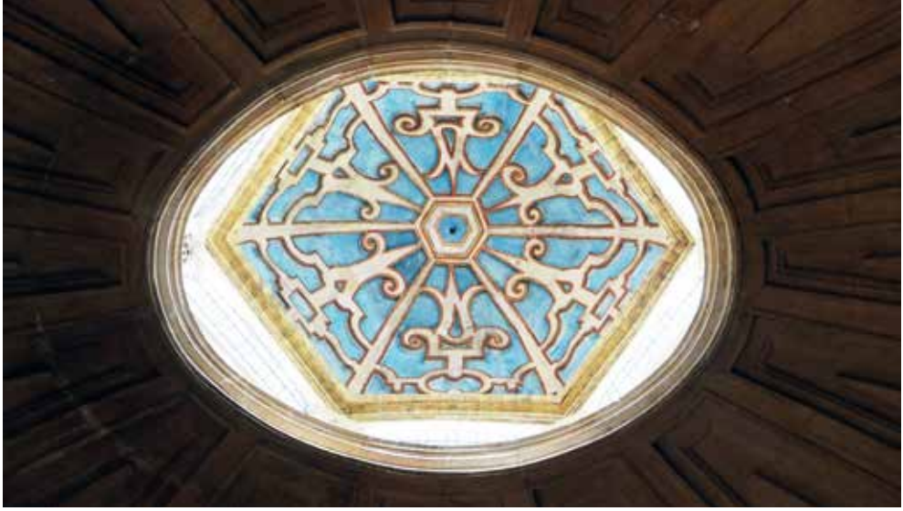
Fig. 39. Linterna de la capilla.
