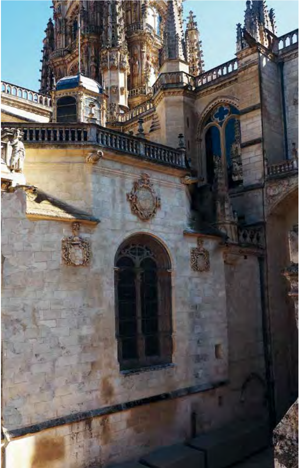
Fig. 20. Exterior de la capilla.
