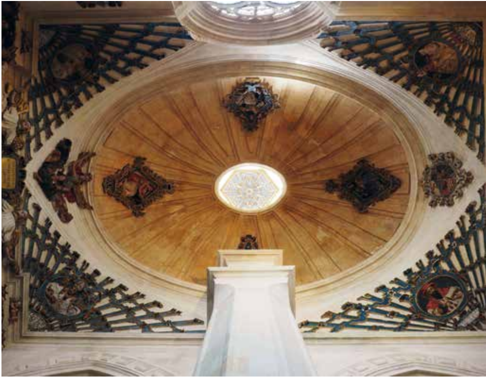
Fig. 43. Bóveda oval de la capilla.
